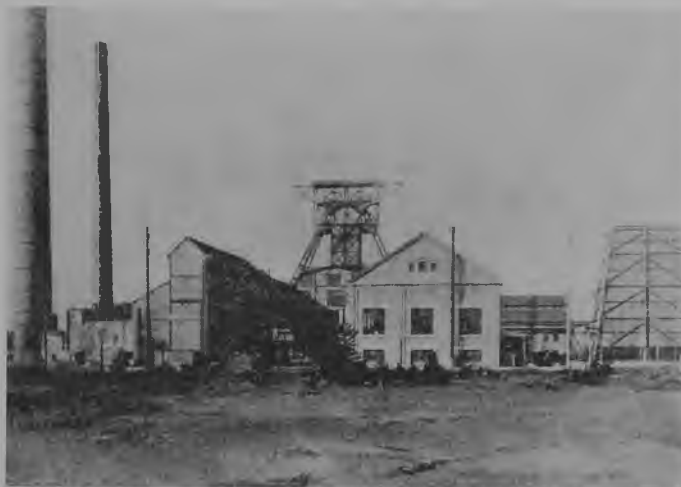
59. Podwójne urządzenie wyciągowe w kopalni „Książ” w Wesołej
