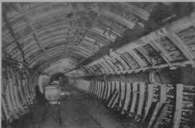
52. Podatna obudowa żelbetowa
