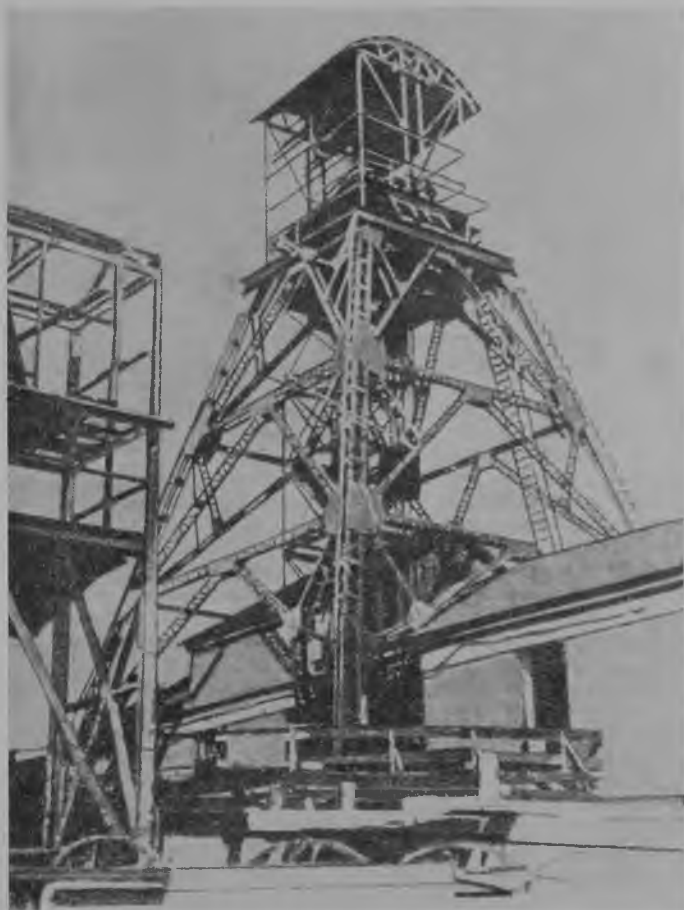
54. Stalowa wieża szybowa w Zagłębiu Donieckim, zbudowana w latach międzywojennych
