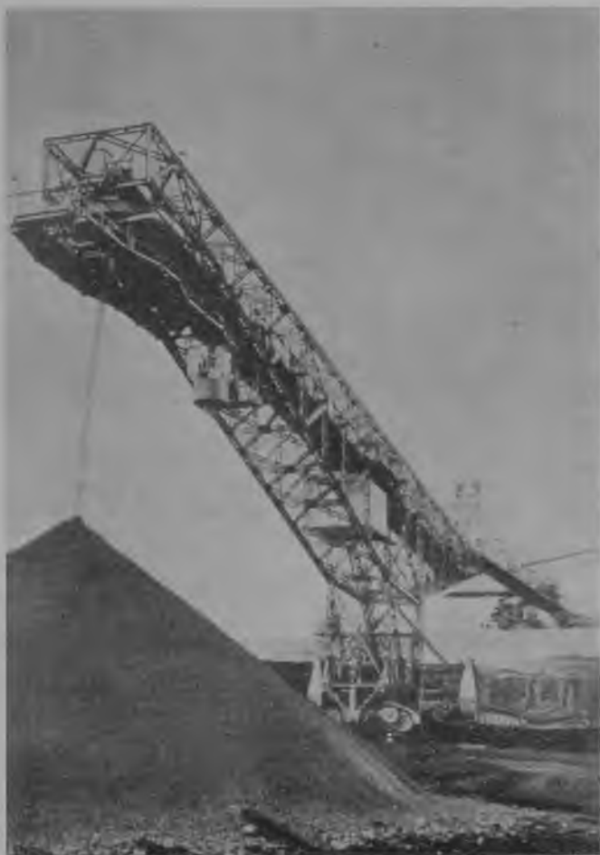
46. Most do transportowania zdjętego nadkładu w kopalni odkrywkowej
