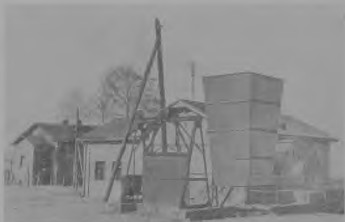
55. Urządzenie do oczyszczania wody i wentylator w kopalni „Waleska” na Górnym Śląsku
