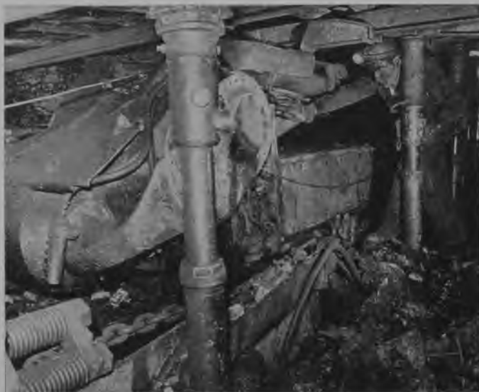
82. Kombajn węglowy i zmechanizowana obudowa w kopalni „Staszic” w Katowicach
