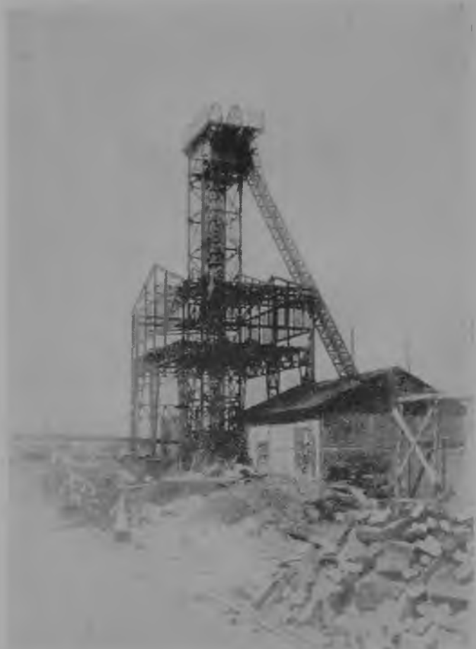
27. Budowa szybu wydobywczego w kopalni „Modrzejów” (1900 r.)
