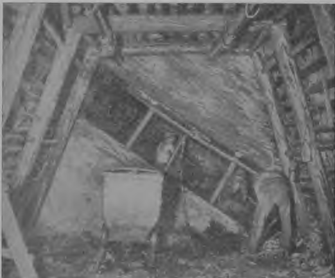
22. Wybieranie cienkiego pokładu węgla przy drażeniu chodnika
