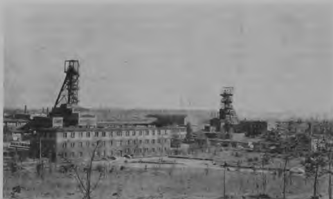
103. Kopalnia „Julian” w Piekarach Śląskich, oddana do eksploatacji w grudniu 1954 r.
