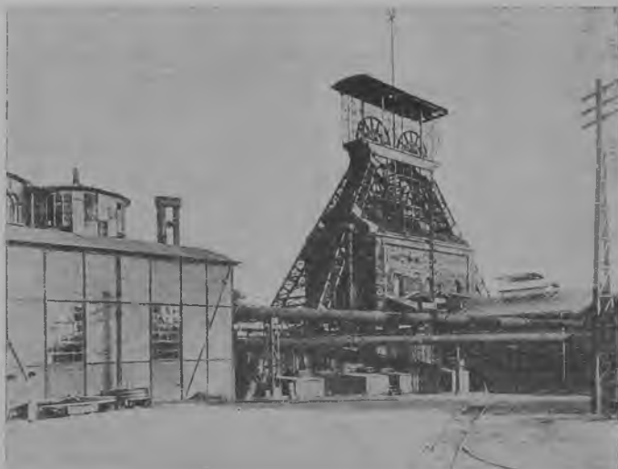
29. Podwójne urządzenie wyciągowe na szybie „Hugo” kopalni „Hrabina Laura” w Siemianowicach
