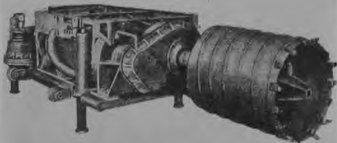
83. Kombajn wierzący „Joy AD2” z cylindryczną głowicą urabiającą
