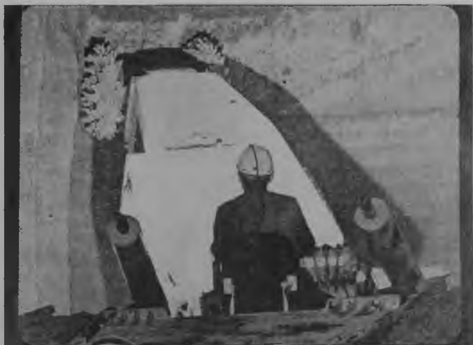
87. Kombajn chodnikowy firmy „Westfalia”
