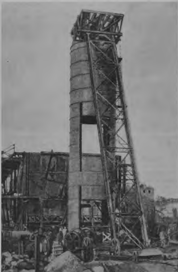
74. Okrągła wieża szybowa, zbudowana w ZSRR ze standaryzowanych elementów, konstrukcji M. M. Zerbina
