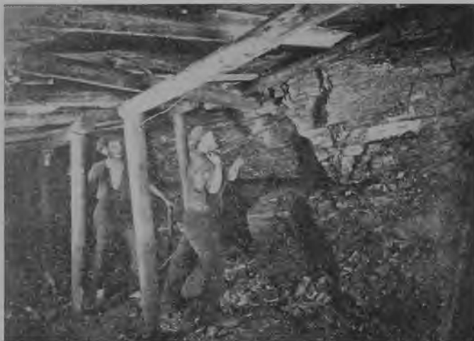
50. Wiercenie otworu strzałowego mechaniczną wiertarką
