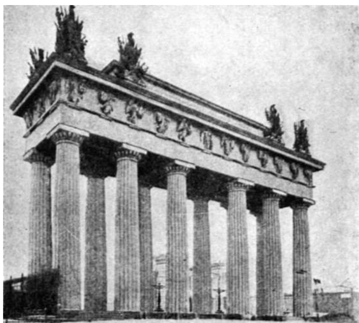
172. Brama Triumfalna w Leningradzie. Archit. W. P. Stasow.
