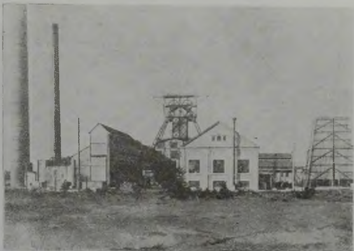
Podwójny szyb wyciągowy w kopalni Książę w Wesolej w latach dwudziestych XX w.
