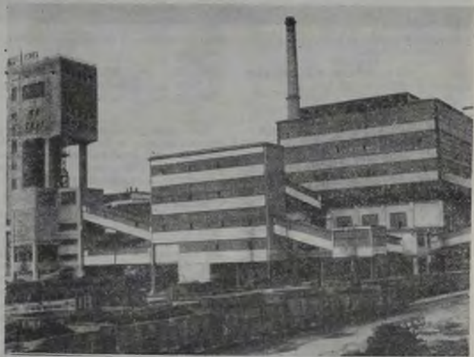
Zakład przeróbczy kopalni Moszczenica w 1967 r.
