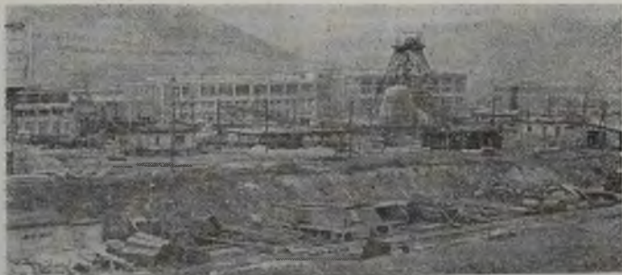
Kopalnia Słupiec w Słupcu — budowa szybu Nowy I około 1964 r.
