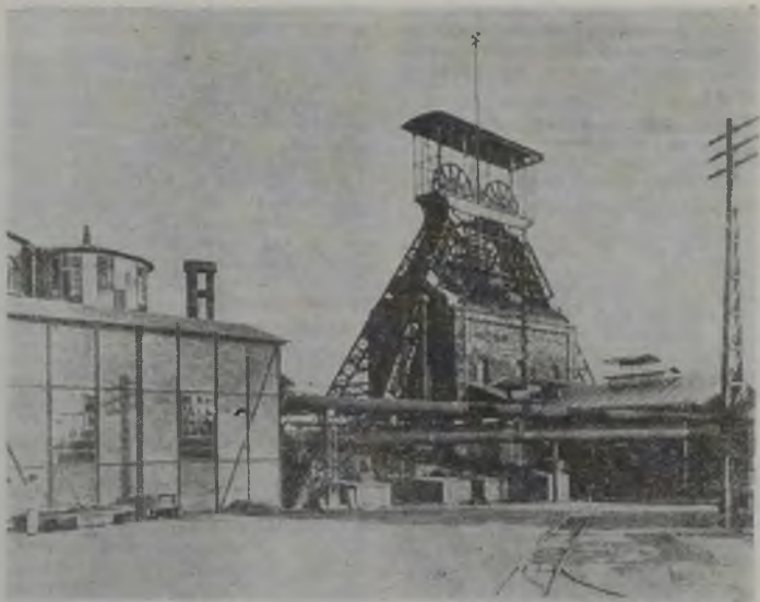
Kopalnia Chorzów (Hrabina Laura) w Chorzowie — podwójne urządzenie wyciągowe na szybie Hugo około 1920 r.
