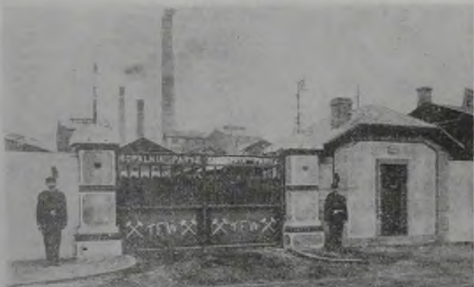
Brama kopalni Paryż w Dąbrowie Górniczej w latach międzywojennych
