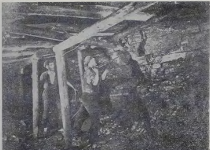
Wiercenie otworu strzałowego wiertarką mechaniczną w latach międzywojennych (kopalnia Wujek ?)
