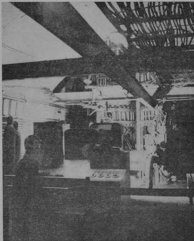
Ryc. 38. Hydrotransport w kopalni „Andaluzja” — komora dawekowników. Ze zbiorów Zarządu Głównego Stowarzyszenia Inżynierów i Techników Górnictwa (ZG SITG)
