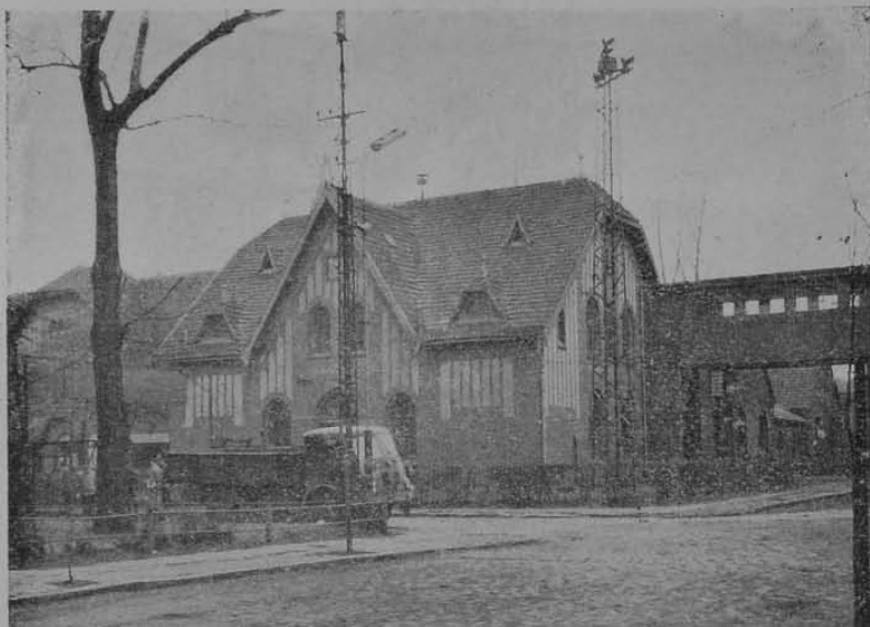
Ryc. 4. Kopalnia „Boże Dary” w Kostuchnie — stary budynek administracyjny. Ze zbiorów Jaworznicko-Mikołowskiego Zjednoczenia Przemysłu Węglowego (JMZPW)
