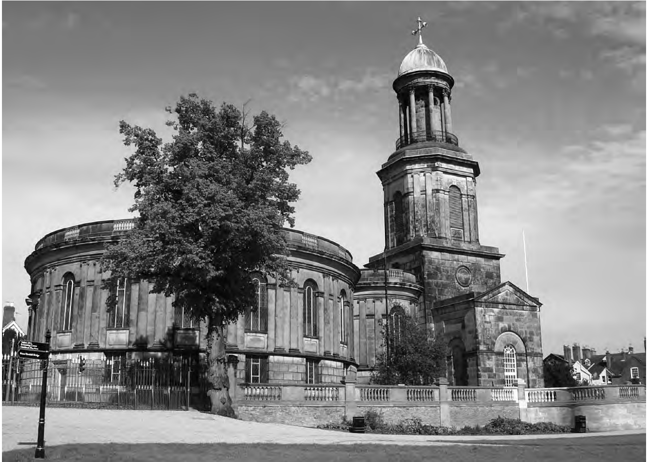
109. George Steuart, kościół św. Chada, 1790–1792, Shrewsbury
